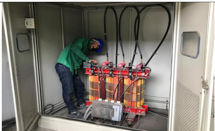
Mantenimiento transformador
